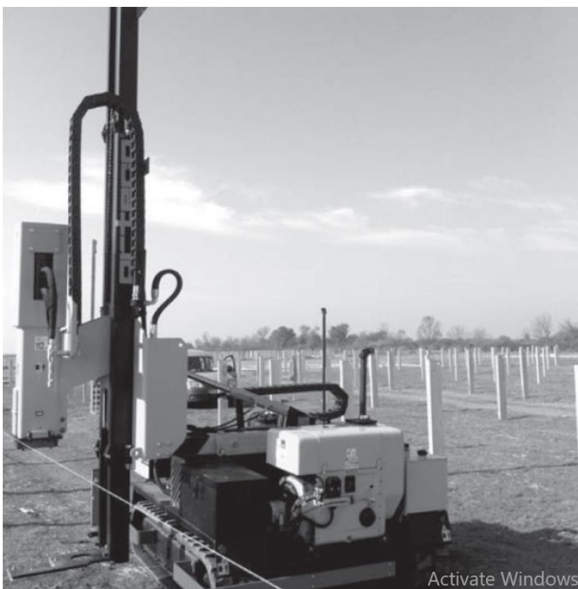
Фигура VI-04. Машина за хидравлично набиване на вертикалните носещи елементи
